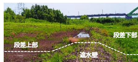
ボグ再生に向けた遮水整備状況
